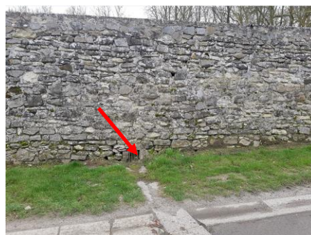
Exutoire pluvial en façade de la parcelle n°126 (trouée existante au pied du mur en pierre)
