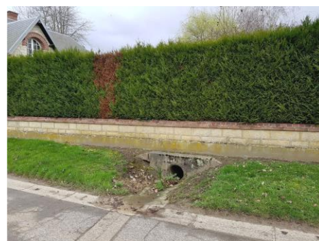
Prolongement de l'exutoire en face (parcelle n°97)
